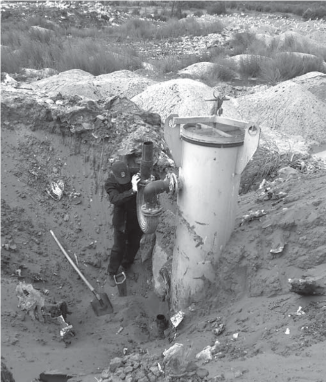
Газовий колектор
