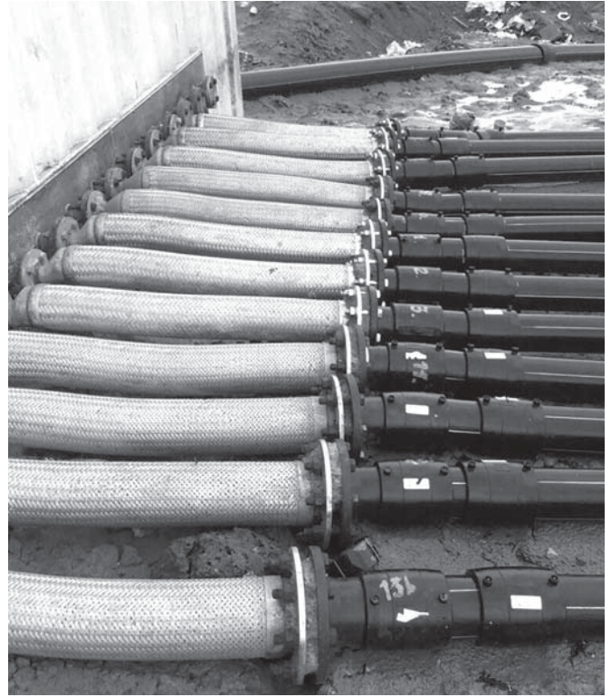
Підключення газопроводів
